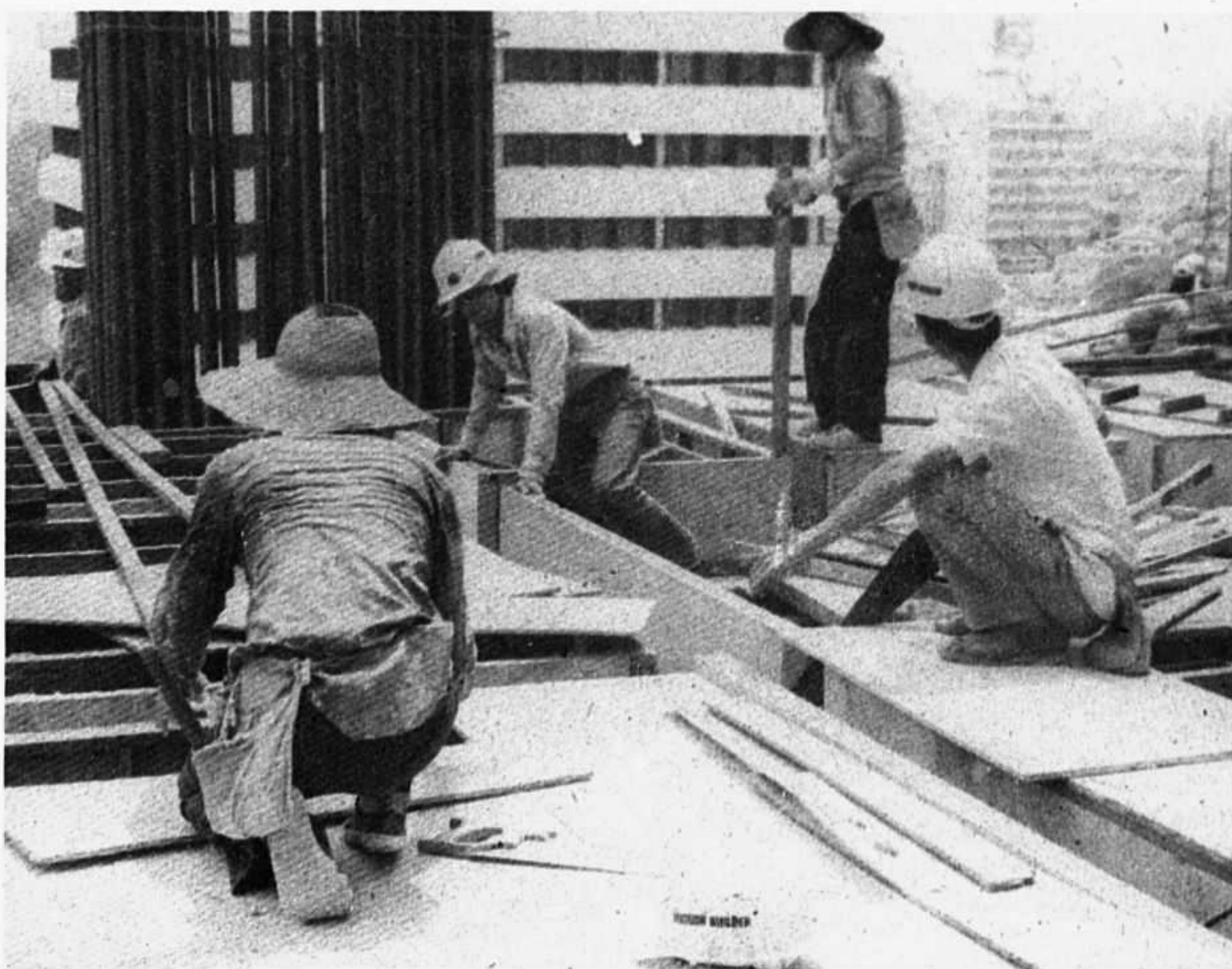
Pekerja membina bangunan mencakar langit.
